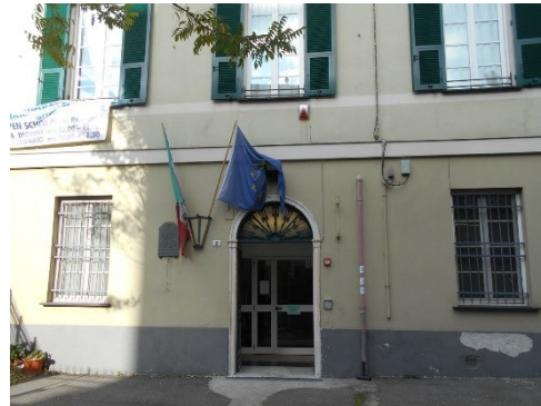
Figura 1.1 - Particolare della facciata principale
