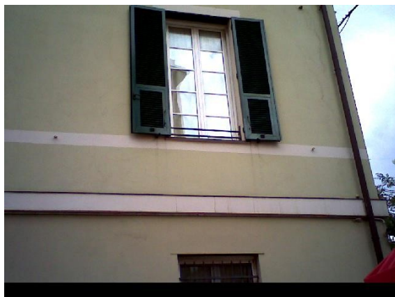
Figura 1.2 – Rilievo termografico della parete
